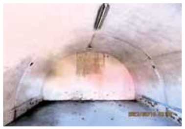
(写真1) 米が濱砲台砲側弾薬庫跡
