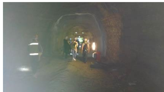
貝山地下壕内部
